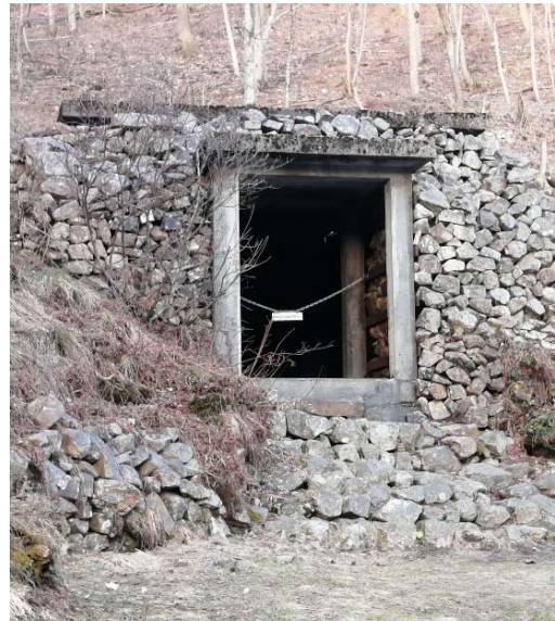
写真 1 : 現在の長走風穴 3 号倉庫
